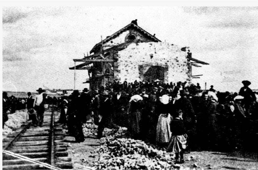
Imagen de la primera estación aún en obras. Foto donada por D. Manuel García-cano Sánchez.
