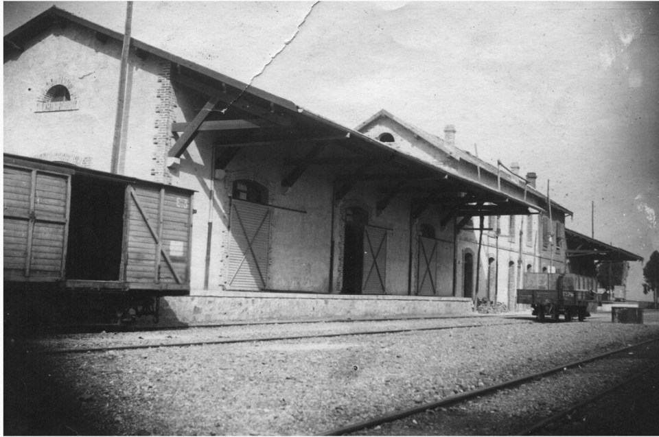
Vista frontal de la estación. Acceso a las vías. Foto ADROCHES.
