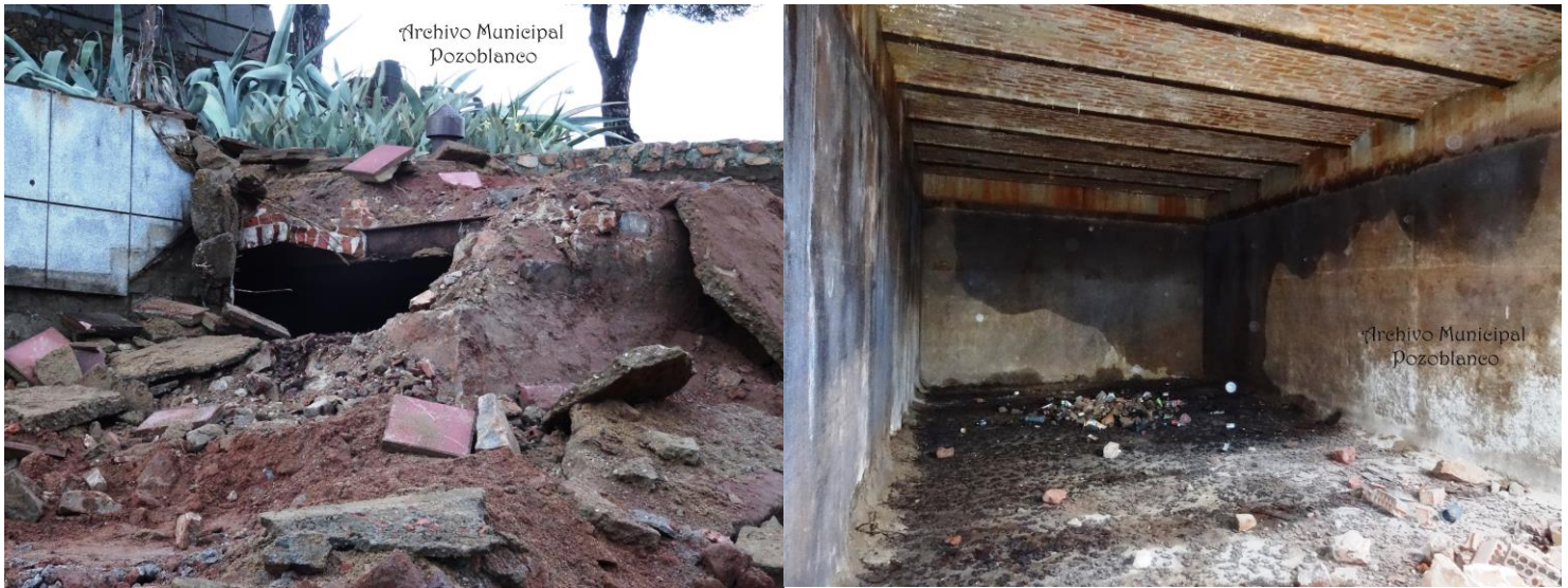
Depósito de aguas de La Garganta durante las obras de remodelación del entorno de la Cruz de la Unidad.
